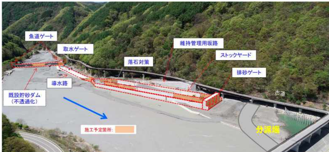
ストックヤード施設施工状況及び予定(令和2年5月撮影)
