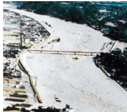
S58.9災害 飯田市松尾地区
