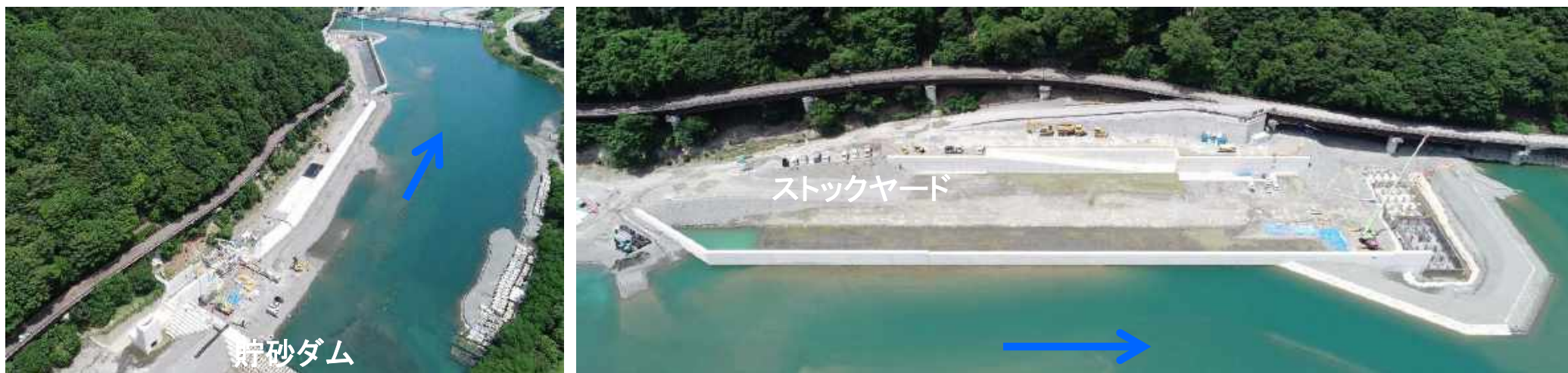
＜ストックヤード施工状況(令和元年7月撮影)＞
