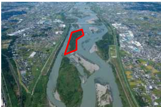
樹木抜開予定箇所（5 k 付近の例）
