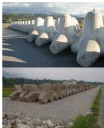
根固めブロックの備蓄
