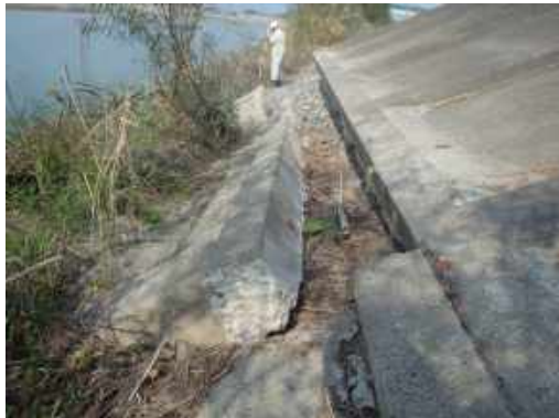
河川管理施設の点検
