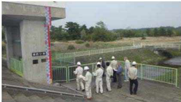
樋門の定期点検
