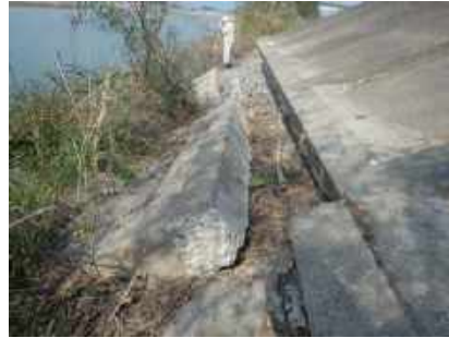
河川管理施設の点検
