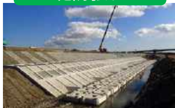
扇頂部対策 (左岸21.4k付近)
