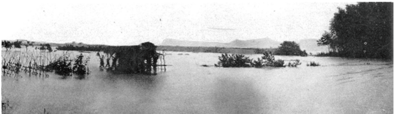
一部堤防を残して浸水した飯田市松尾鎌岩地籍
