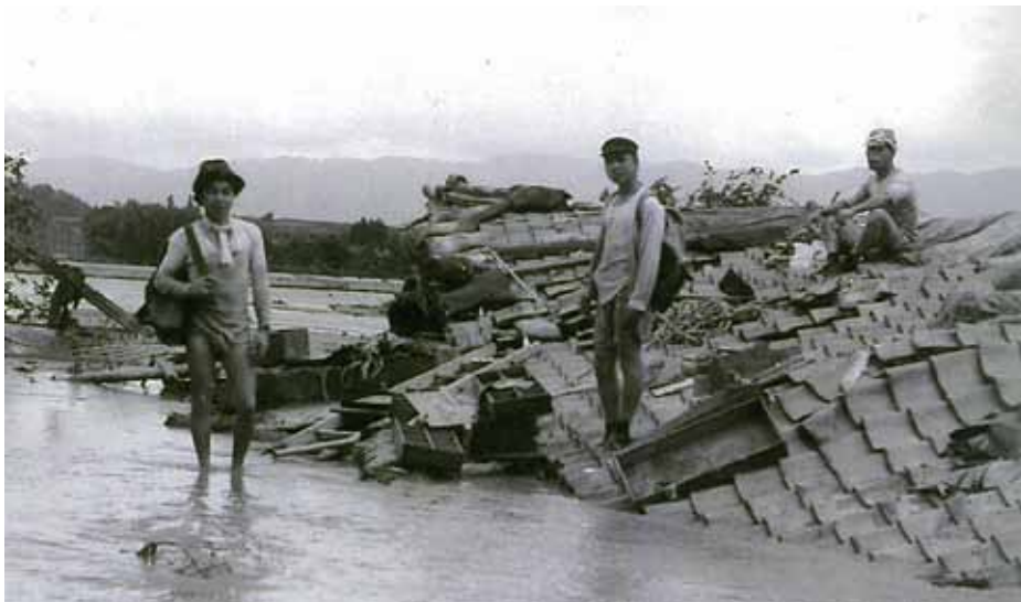
蚕室まで浸かった民家 2 階建ての蚕室が屋根まで砂で埋まってしまった。左側は土蔵で、埋まった砂の上を水が流れている
