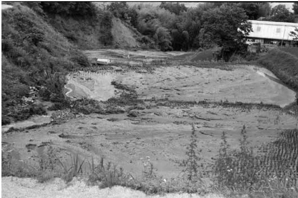
壬生沢川からの土砂に埋まった農地
