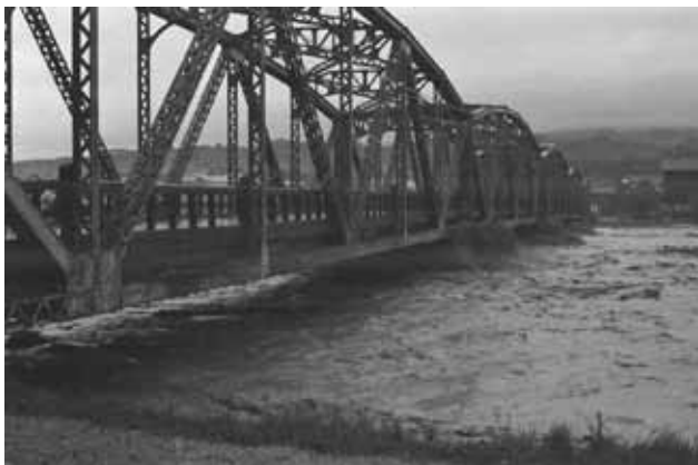
明神橋の橋げたに打ち付ける濁流
