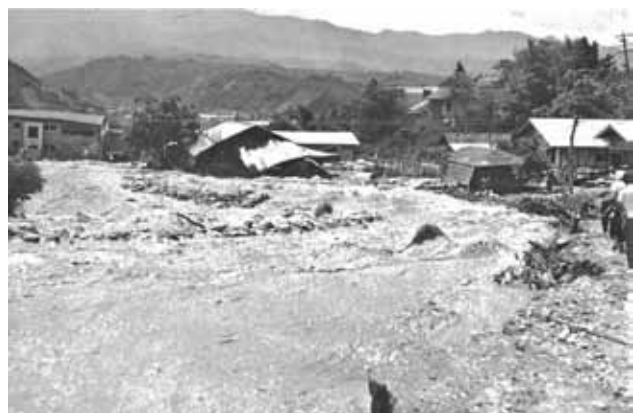
竹村医院の上流付近の大島川の氾濫
