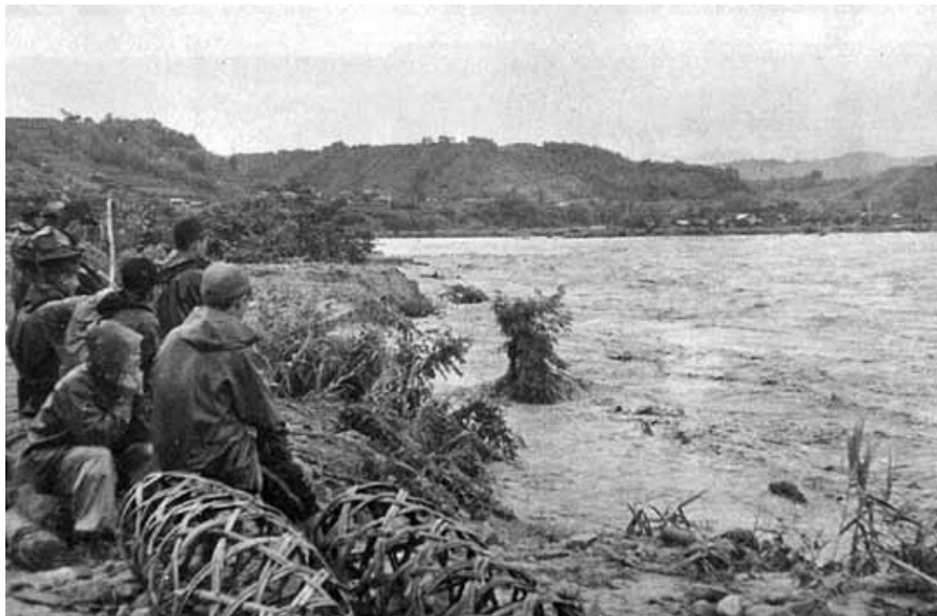
下平の天竜川堤防の水防作業。前方は小沼方面
