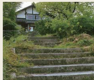
被害の跡の残る寺の石段 現在は残っていない (写真出典:伊那谷の土石流と満水)
