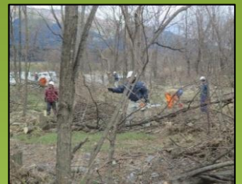
樹木伐採作業
