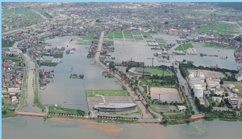
諏訪市豊田：浸水状況
