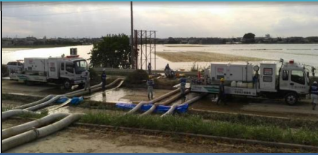
茨城県常総市の浸水箇所での排水作業(天竜川上流の照明車・排水ポンプ車 H27.9/10~18)
