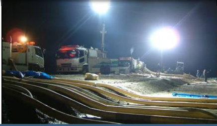
照明車と排水ポンプ車による排水作業 (天竜川上流の照明車・排水ポンプ車H23.3/14~5/9)
