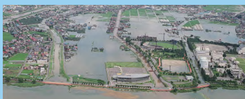
諏訪市豊田：浸水状況
