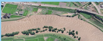
箕輪町北島：堤防決壊
