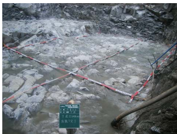
基盤面の整正（岩盤）
