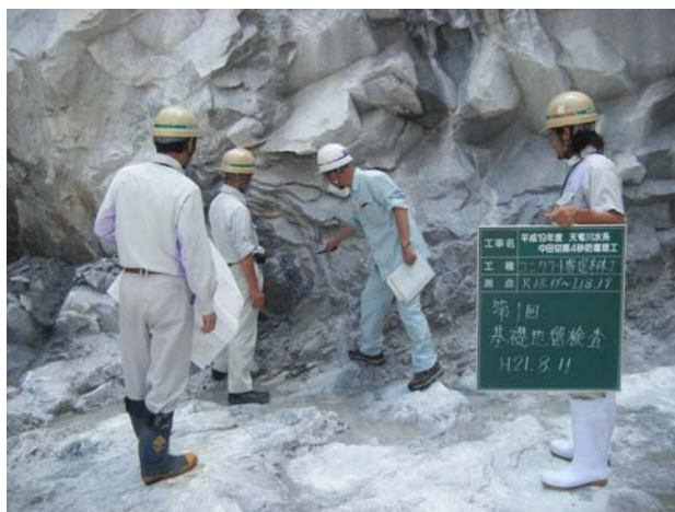
基礎地盤検査（現地確認）
