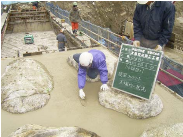
天端の仕上げ（コテ仕上げ）
