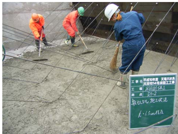
敷きモルタル施工状況
