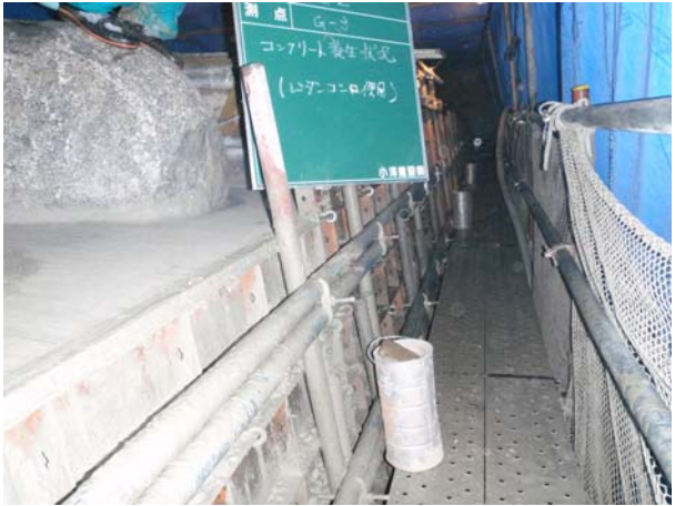
堤冠部の給熱養生（練炭）
