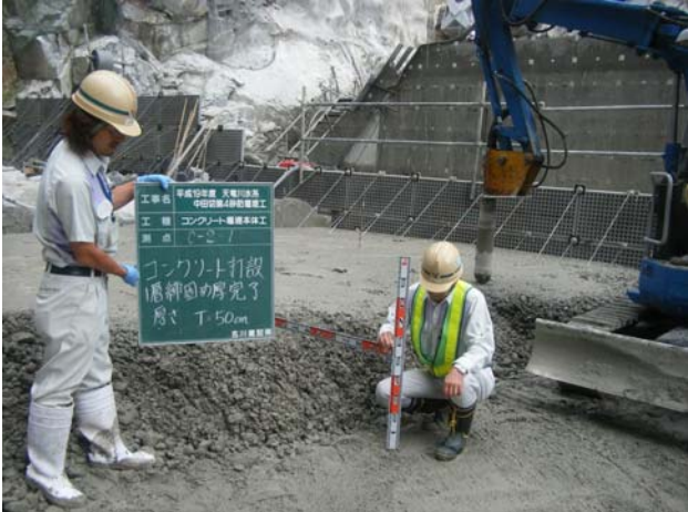
締固め厚の確認（T=50cm）
