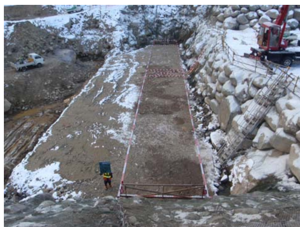
基盤面の整正（土砂）
