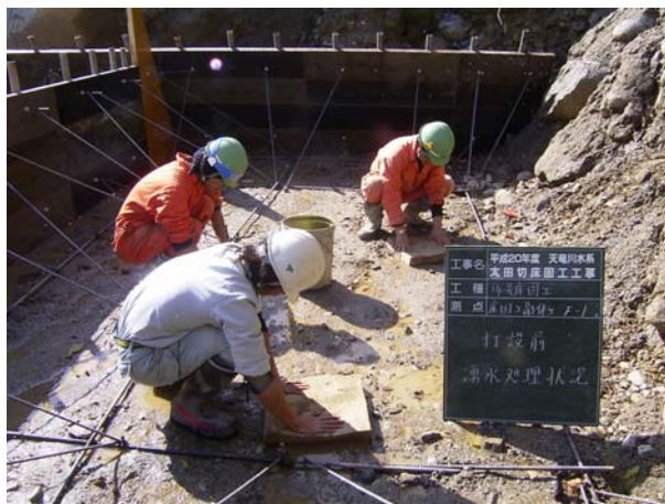
基盤面の湧水の処理状況
