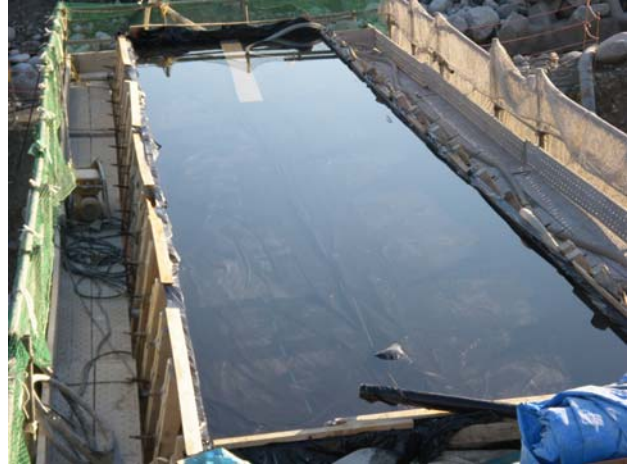
湛水養生の例
