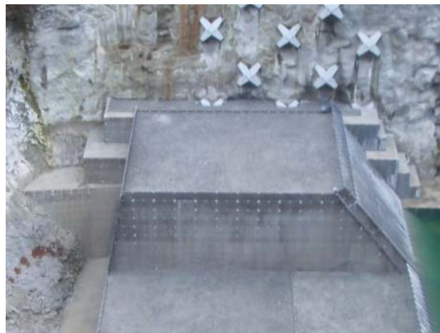
間詰め例（くさび型とブロック型）
