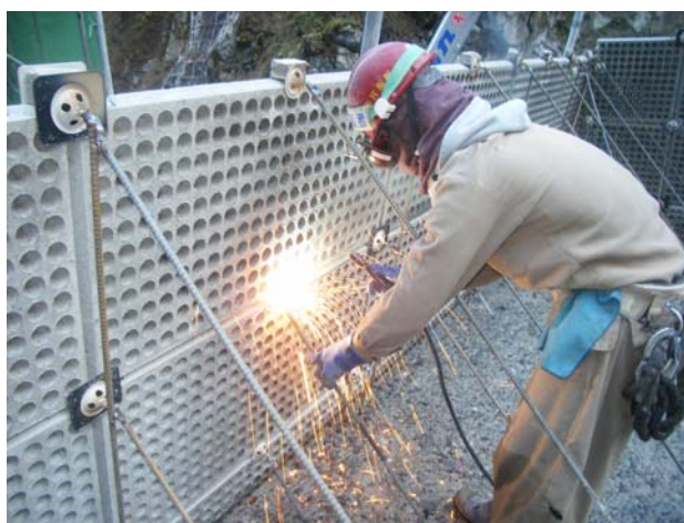
プロテックピアス設置
