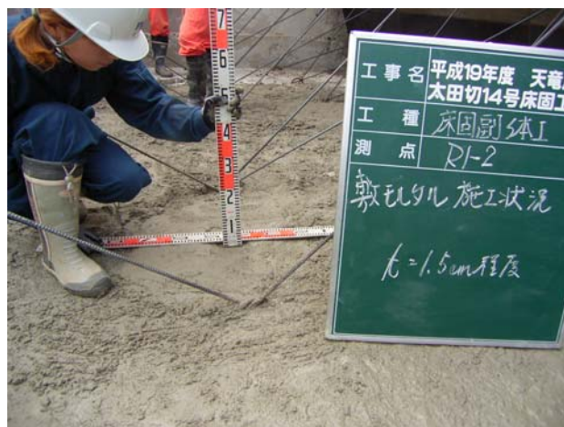
敷きモルタルの厚さ確認
