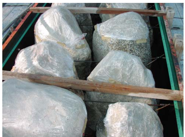
転石養生状況
