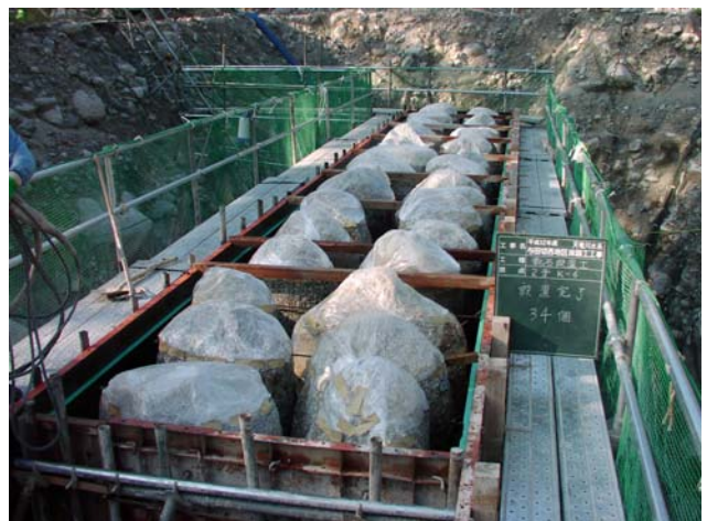
転石設置状況
