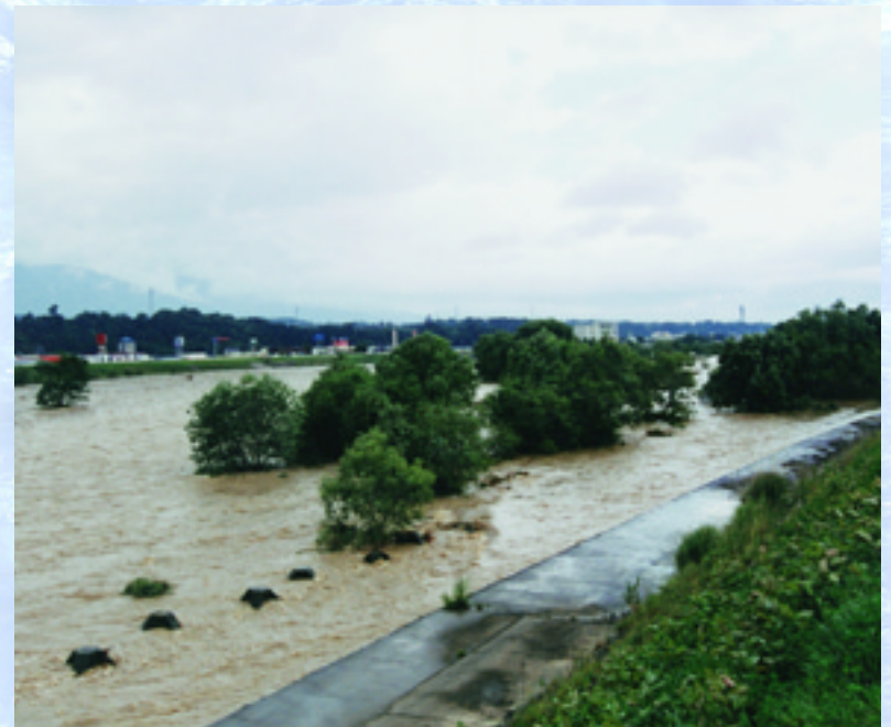
平成11年6月の洪水時の状況（伊那市付近）
