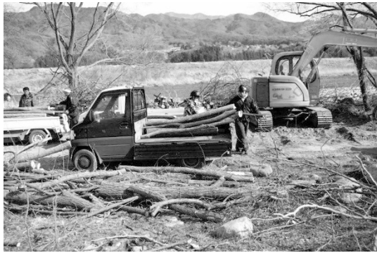
伐採木の軽トラックによる搬出
