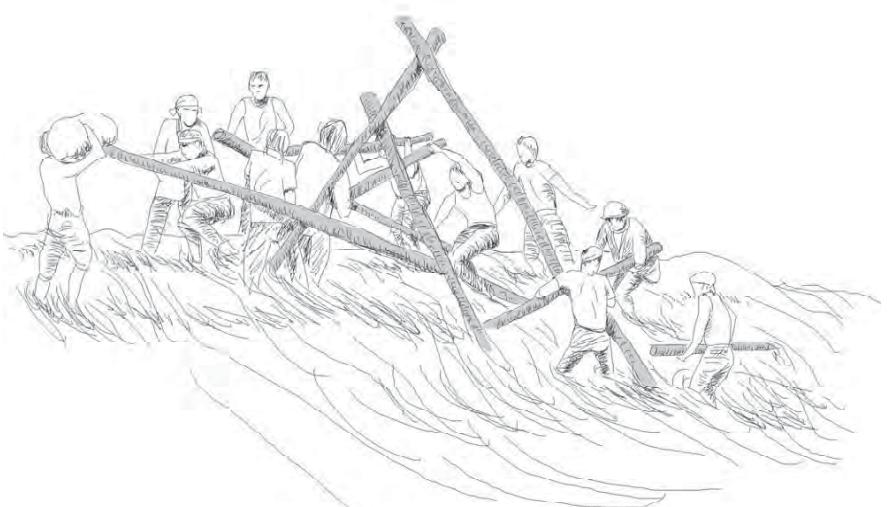
図 10：水防時の聖牛組み立て想像図
