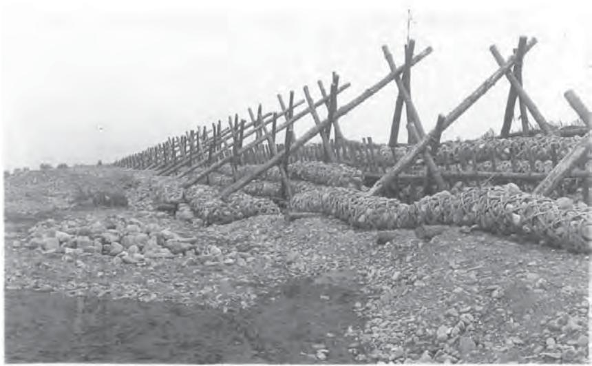
写真 12：昭和 13 年工事での牛枠と竹の蛇籠
