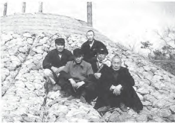
写真 18：北原式鉄線蛇籠（大泉川 荒井坂橋 橋台）
