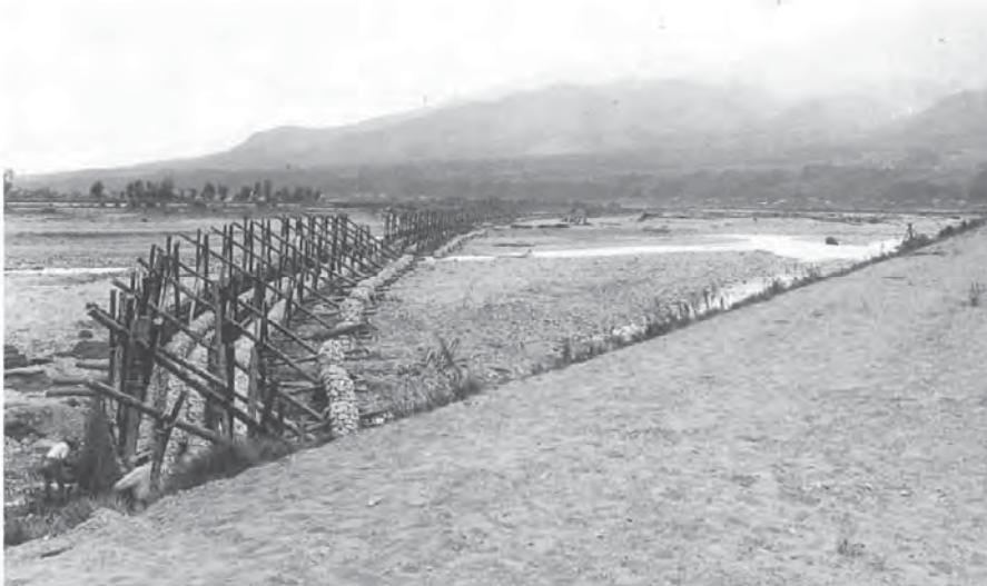
写真 13：昭和 13 年下島破堤後、締切りのための牛枠
