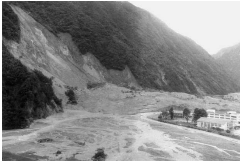
大西山(大鹿村)の土砂崩落(S36.6.29)
