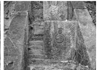
写真-1/石造り尺単位の量水標 6~14段が確認できる。1段の高さは1尺(30.3cm)になっている。1段の左に1寸(3.03cm)単位の小段も付けられ寸単位での観測ができるようになっている。歴史的価値のある量水標と言える。
