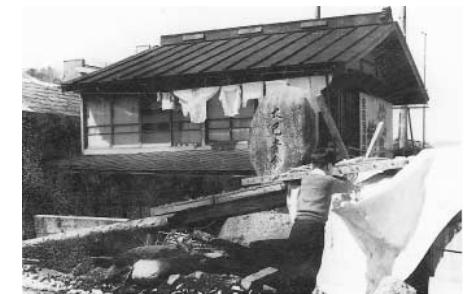
土砂に埋まった沢渡の民家(伊那市沢渡)
