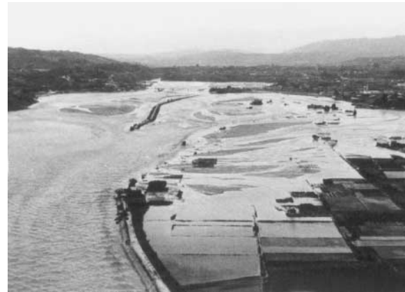
飯田市松尾地区破堤(S36.6.)
