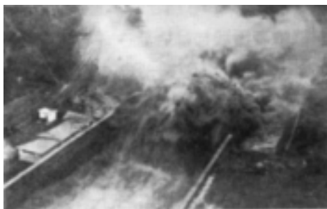
写真-12 美和ダムの放水（『濁流のあと』より）
