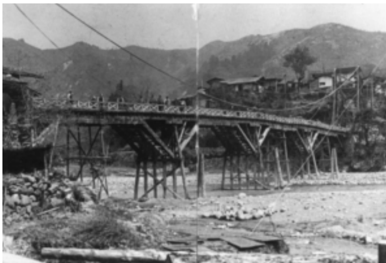
写真－2 吊橋に架替え中の天女橋（大正年間）（写真集『高遠のあゆみ』より）
