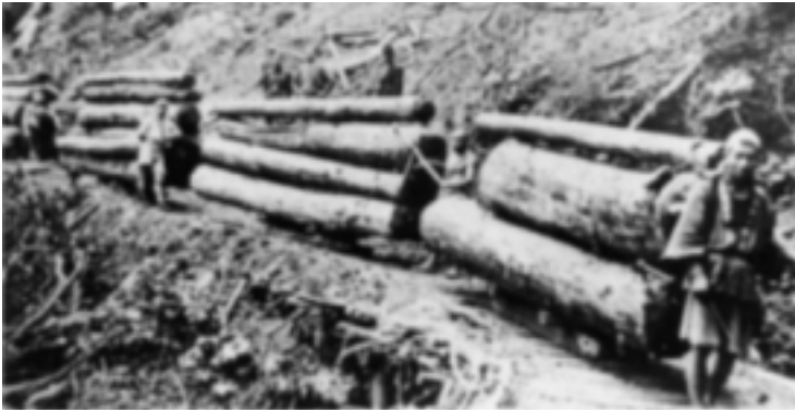
写真－5 木馬による出材（伊那営林署の資料による）
