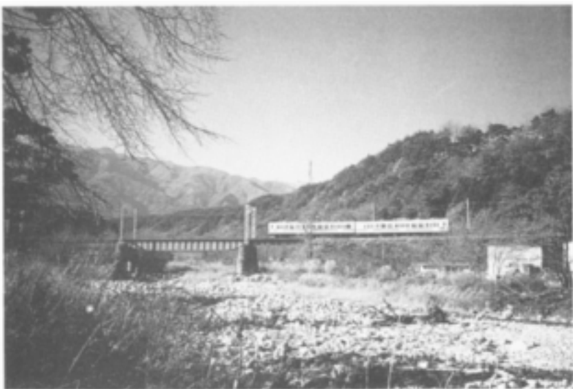
飯田線中田切鉄橋 — 飯島町北河原
