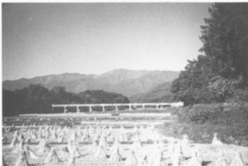
深沢川の谷を渡る旧西天竜幹線水路橋 — 箕輪町大出 (今の水路はサイホンとなり道路橋となっている)
