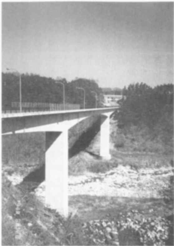
中田切ふれあい橋（飯島町より駒ヶ根市側を望む）
