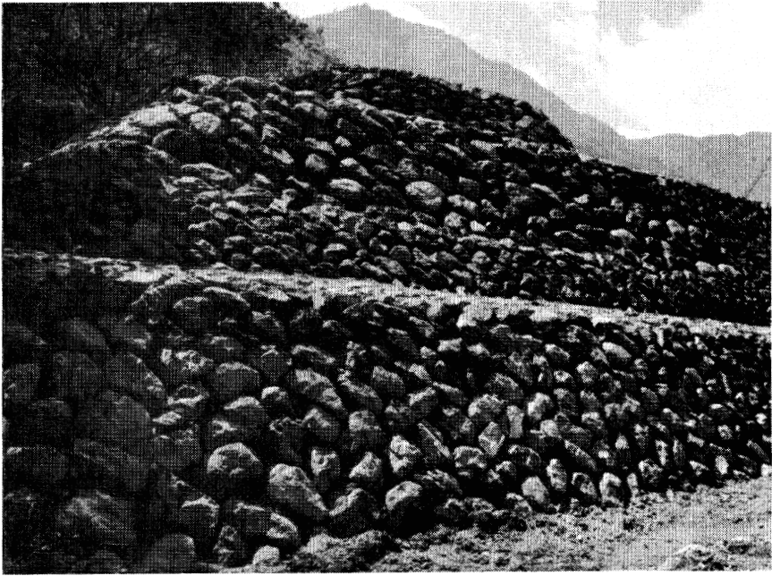
6. 御勅使川にある巨大な「石積み出し」(信玄にかかわると伝えられる) (『甲斐の道づくり・富士川の治水』より)
