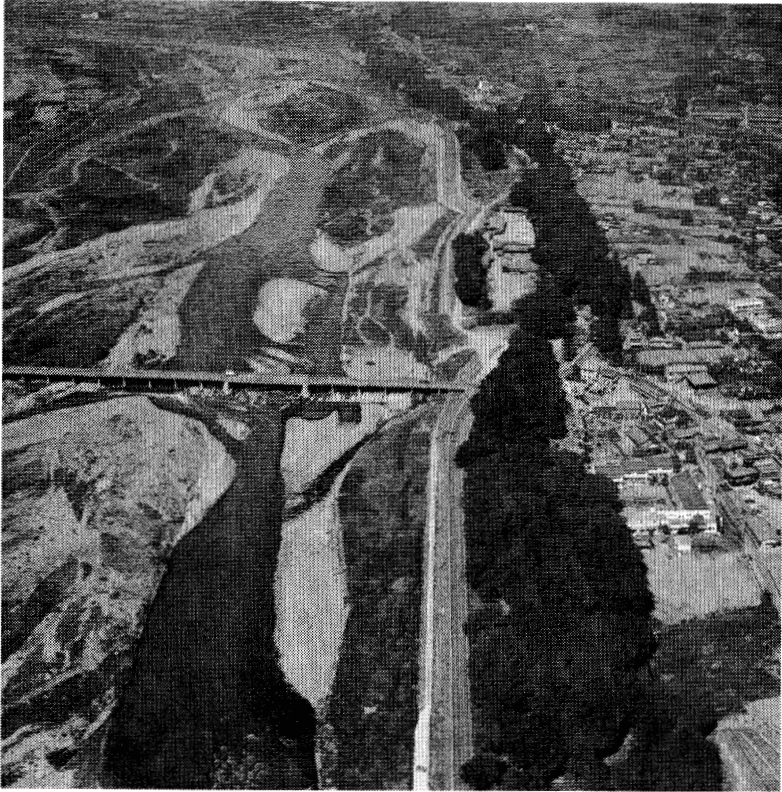
5. 現在の信玄堤 ー山梨県竜王町ー (『甲斐の道づくり・富士川の治水』より)
