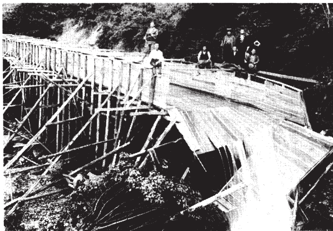
昭和11年5月30日の災害によって破壊された粹立
