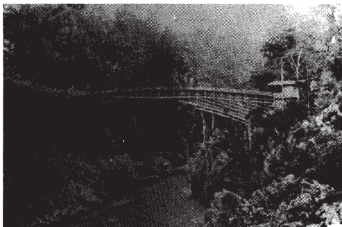
▲ 明治10年初めて架けられた刎橋式架橋で太田橋と言ったが、明治15年鳴鶴が姑射橋と名付けた。
