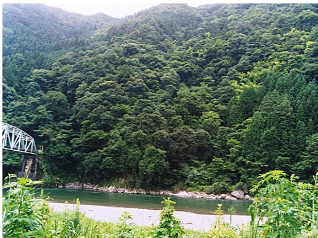
天龍村天竜川橋付近
