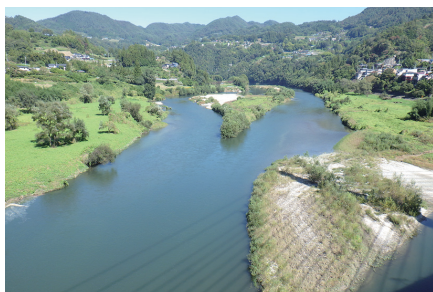
【泰阜村】南宮大橋から上流（平岡ダム湛水域）
