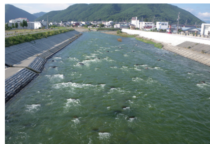
【辰野町】横川川合流部付近
