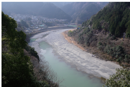
【天龍村】平岡橋（平岡ダム下流）
