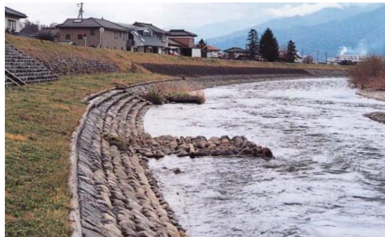
魚をはじめとする生物の生息環境に配慮して、多自然型工法を用いた護岸。（伊那市の天竜川）
