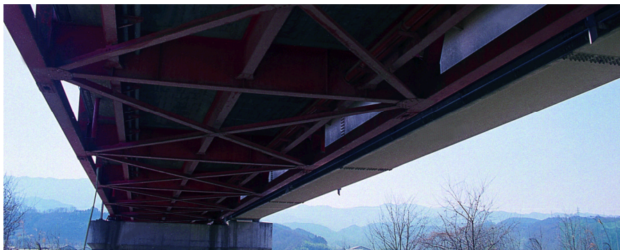
このような構造の橋は多くの鳥が営巣する（阿島橋）
