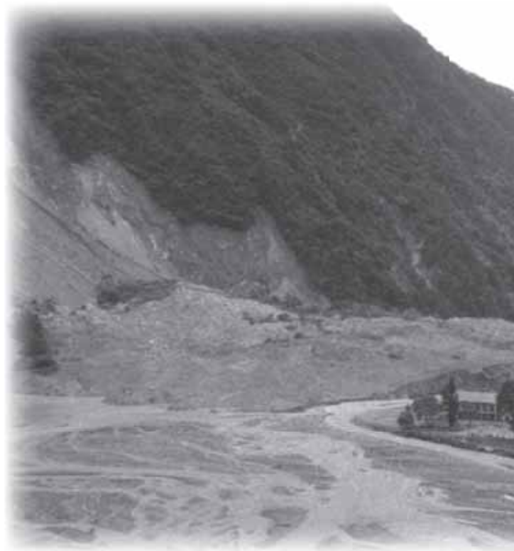
崩壊した大西山(手前は小渋川)
