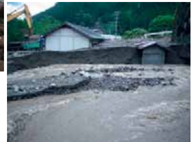
平成22年7月豪雨により、飯田市上村地区において発生した土石流により土砂が流入した集会所
