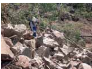
奈良県十津川村地先の天然ダム下流部にて調査測量を実施
