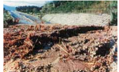
中央自動車道松川～駒ヶ根IC間に堆積した土石流
