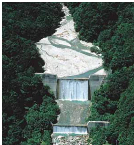
本谷砂防堰堤（太田切川本川）
