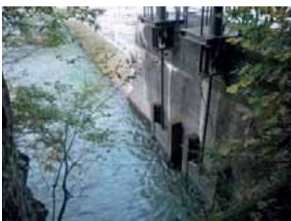
上の井取水口となっている太田切床固工
