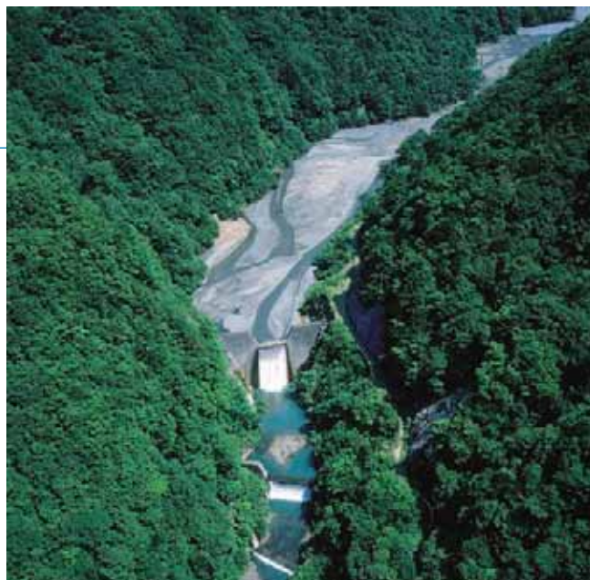
北又沢第2砂防堰堤 (遠山川支川 北又沢)
