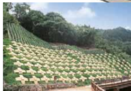
アンカー工が施工された斜面
