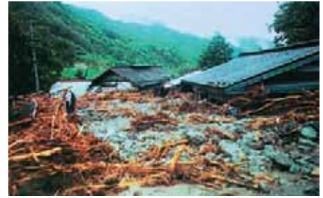
大量の土砂・流木で押しつぶされた家 (伊那市高遠町)
