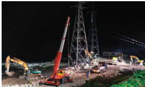
平成18年7月豪雨災害時の応急復旧工事
