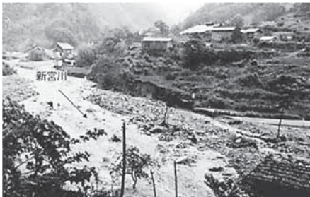
昭和36年6月豪雨で河岸を削って流れる新宮川 (駒ヶ根市中沢落合)
