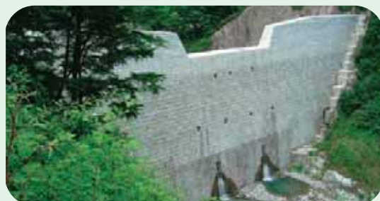
不透過型砂防堰堤(飯島第6砂防堰堤) 与田切川本川
