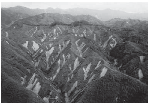
伊那山地の崩壊状況(小渋川上流・四徳川流域)
