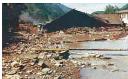
遠山川の氾濫で浸水した旧南信濃村中心部昭和通り
