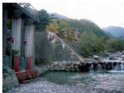
下の井取水口を保全する太田切床固工
