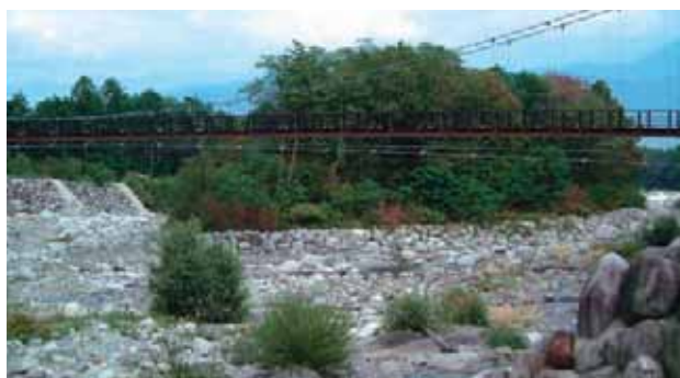
中洲を保全した床固工の整備(太田切川本川)
