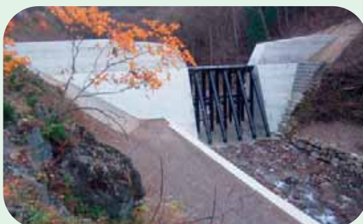
鋼製スリット砂防堰堤(新沢第2砂防堰堤) 新宮川支川・新沢 鋼製スリットは、土砂とともに流下する流木を捕捉します。
