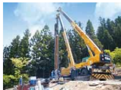
杭工（杭の打ち込み）
