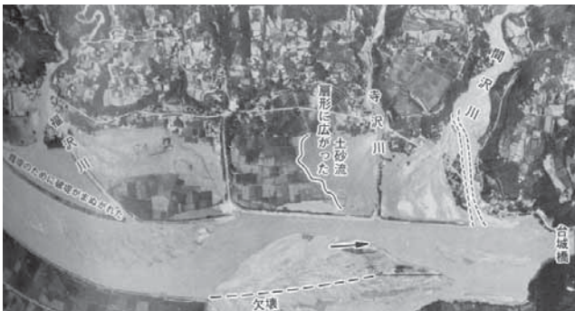
小渋川下流の天竜川本川の被災状況
