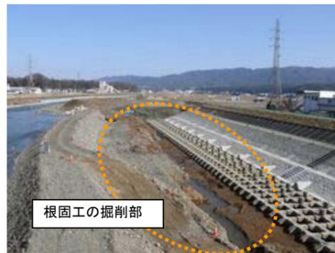
2. 周辺の流水状況や河床高等を参考にし、最終的に復元される流路のイメージを持ちながら、掘削部の埋め戻しを行う。
