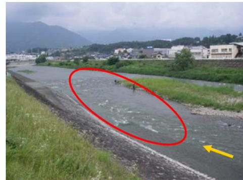
工事箇所付近の河床掘削時に河床からでてきた大石を仮置きしておき、流路のうち、瀬が形成されると予想される箇所を中心に大石の敷設を行う。大石の確保については付近の支川から運搬する方法も考えられる。
