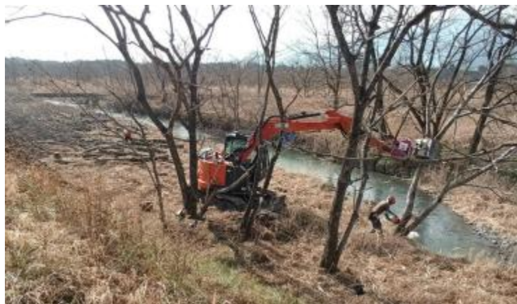
河川維持修繕工事 (施工事例：伐木)
