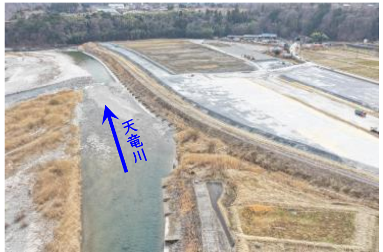
こわだ 小和田地区堤防整備事業 (R8年3月現地状況)
