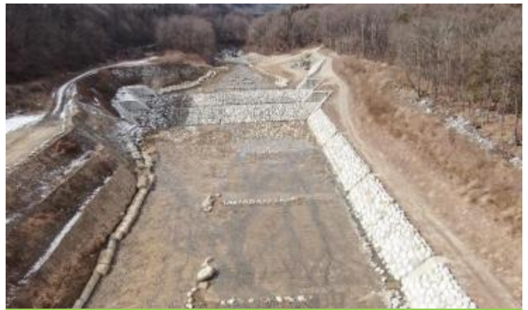
太田切床固工群
