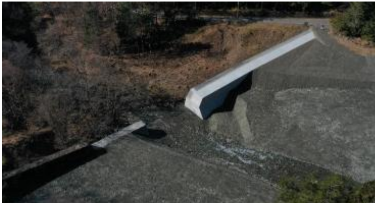
北川第2砂防堰堤改築
