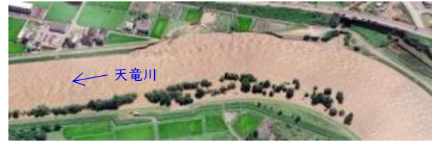
天竜川本川の堤防決壊箇所（箕輪町松島地区）
