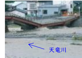
落橋した殿島橋（伊那市）
