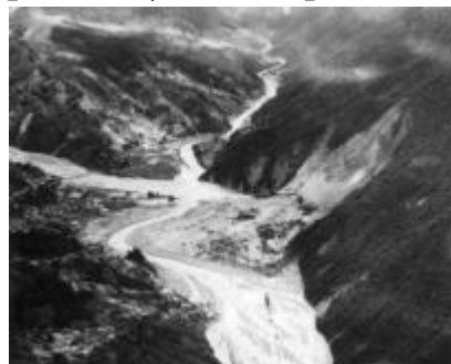
崩壊した大西山
