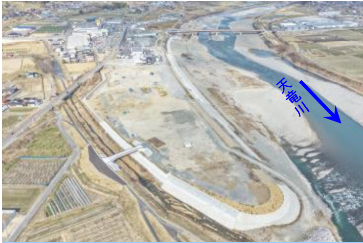
やまがし 山吹地区堤防整備事業 MIZBEステーション整備事業 (R8年3月現地状況)
