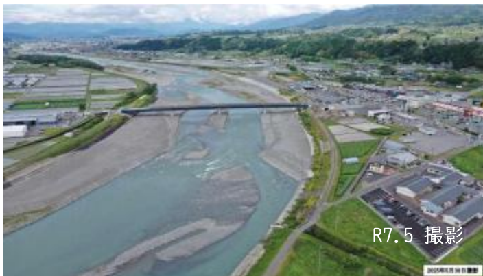
長野県下伊那郡高森町と豊丘村に建設中 「(一)市ノ沢山吹(停)線 竜神大橋」
