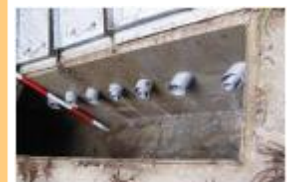
横ボーリング工
