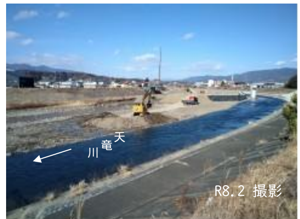
長野県伊那市に建設中 「伊那環状北線 天竜川橋梁」
