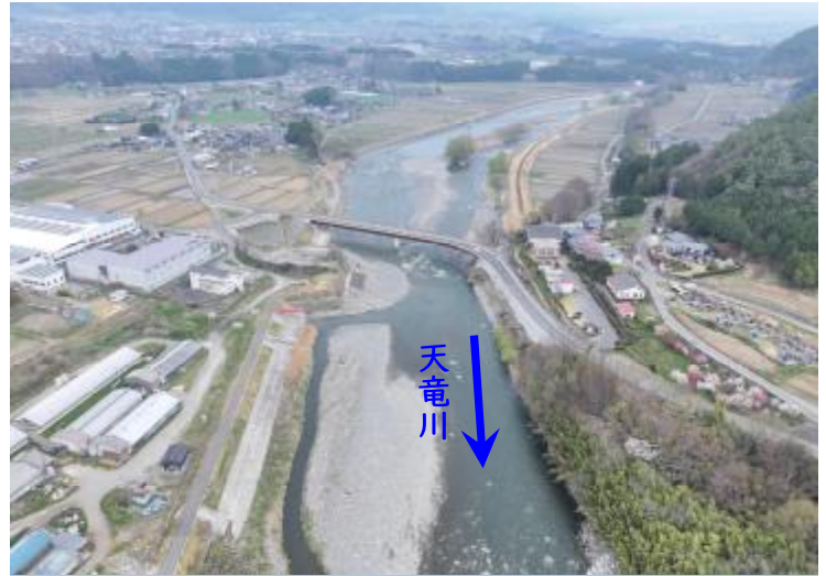
みやだ 宮田地区堤防整備事業 (R8年3月現地状況)
