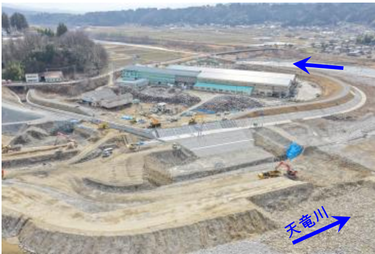
みなかた 南向地区堤防整備事業 (R8年3月現地状況)
