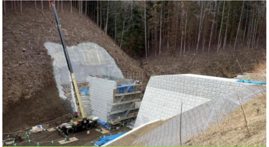
熊倉沢砂防堰堤
