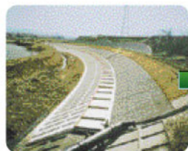
〈コンクリート護岸完成〉 洪水に備え、護岸で堤防を保障。
