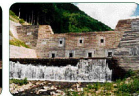
【木製の型枠を使用した砂防施設】 矢立木砂防えん堤(大鹿村)
