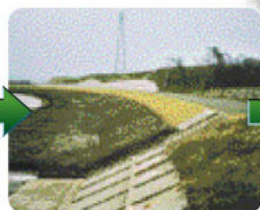
〈コンクリート護岸に覆土〉 可能な限り、工事前のかたちに戻します。
