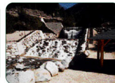
【人工工法の砂防施設】 中御所第2砂防えん堤(駒ヶ根市)
