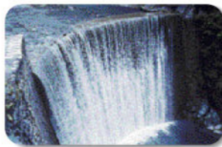
アーチ式砂防えん堤 (上蔵砂防えん堤: 小渋川) 昭和29年に完成した砂防えん堤。土砂による摩擦を防ぐため、表面に切石を張りつけており、今では石積み周辺の緑にとけこんでいます。
