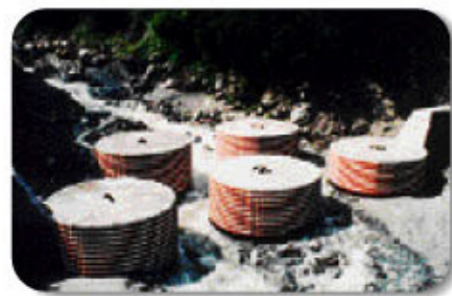
セルダム (与田切崩壊セル群ダム: 与田切川) 銅製の筒の中に現地の石を詰めて造られたえん堤。小規模の土石流を通過させ巨石や流木だけをせき止めるもので、工期の大幅な短縮と低コストを可能にしました。
