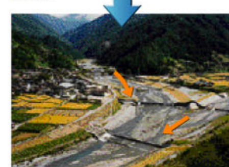
現在では、床固工群の整備が進み、災害に対する安全性が向上しています。
