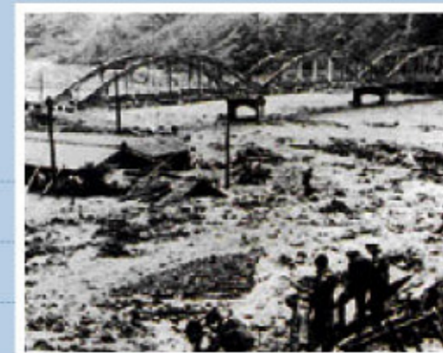
土砂災害を受けた小波橋付近(大鹿村・大河原)
