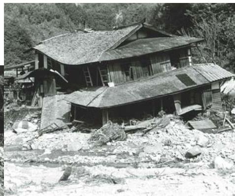
土石流で傾いた家
