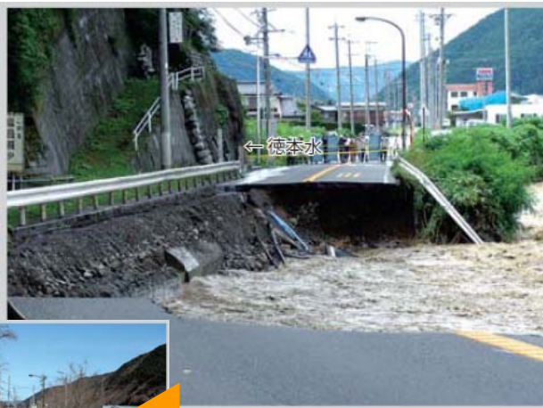
増水でとぎれた道路（徳本水） 提供：辰野町役場
