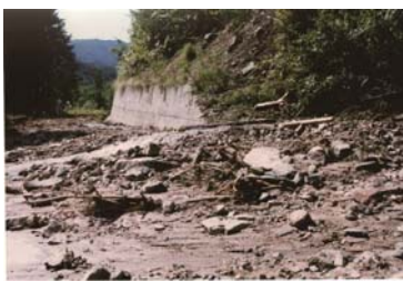
土石流被害（売木村）
