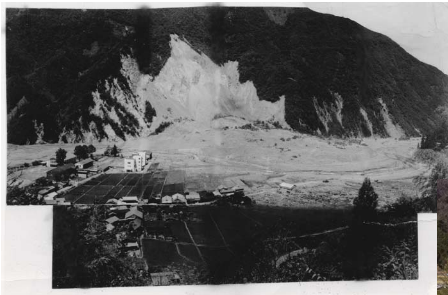
大西山から小沢川に大量に流れ込んだ土砂
