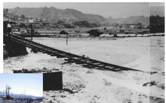
宙づりとなった 飯田線の線路
