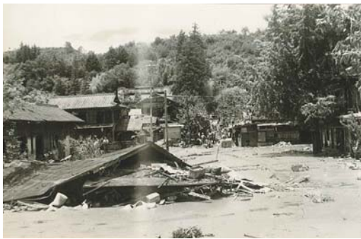
土砂で埋め尽くされた川路駅前付近 提供：飯田市立図書館
