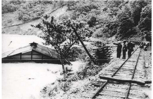
建物と森林鉄道が流出した戸草（伊那市長谷） 提供：伊那市役所
