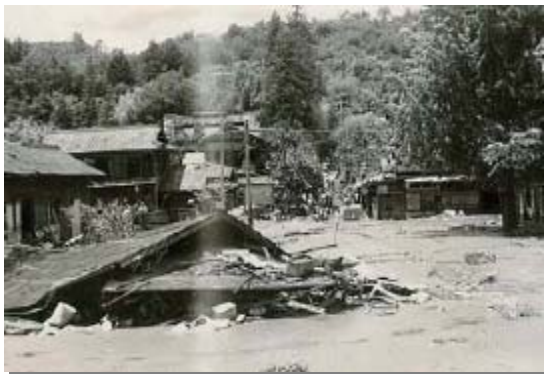
土砂で埋め尽くされた川路駅前付近
