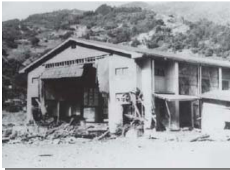
崩落時の風圧で壊れた大鹿小学校体育館
