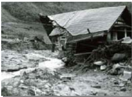
破壊され傾いた農協支所
