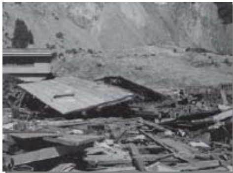
大西山崩壊地の対岸へ押し流された家屋
