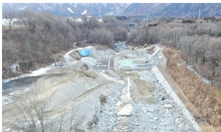
太田切床固工群
