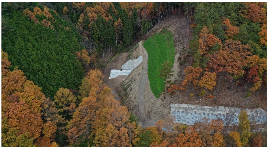
熊倉沢砂防堰堤
