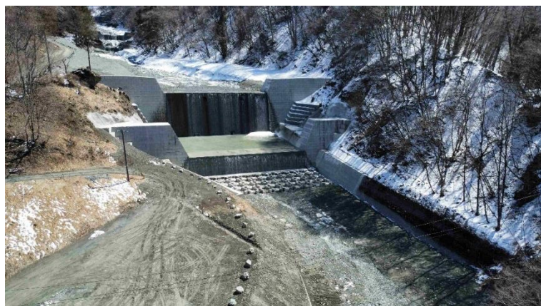
手開沢砂防堰堤改築
