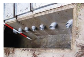
横ボーリング工
