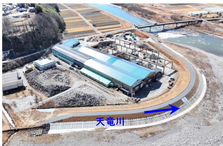
みなかた 南向地区堤防整備事業（R7年2月現地状況）
