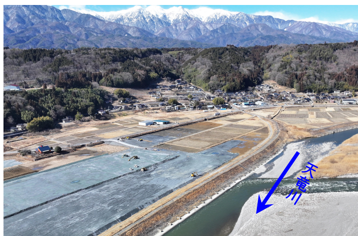
こわだ 小和田地区堤防整備事業（R7年2月現地状況）
