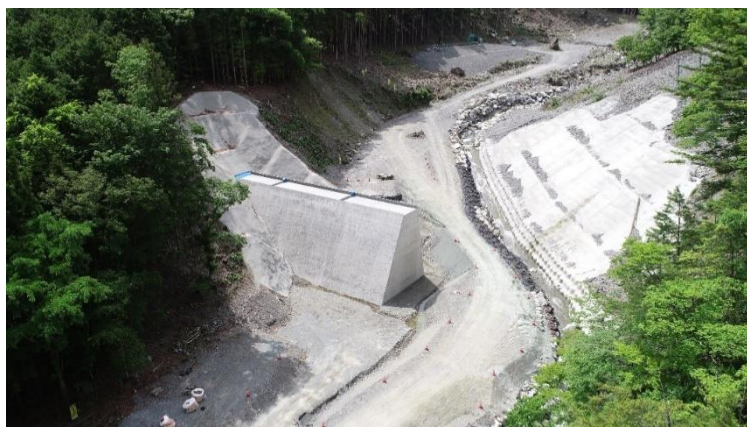
小嵐第3砂防堰堤
