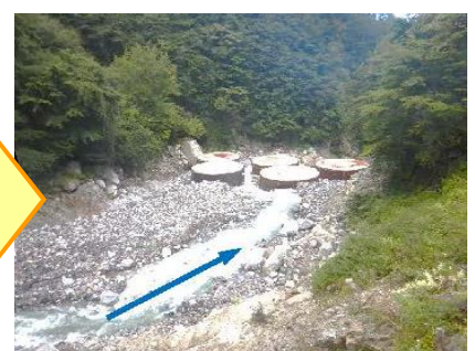
土石流発生後 (R4.9.2)
