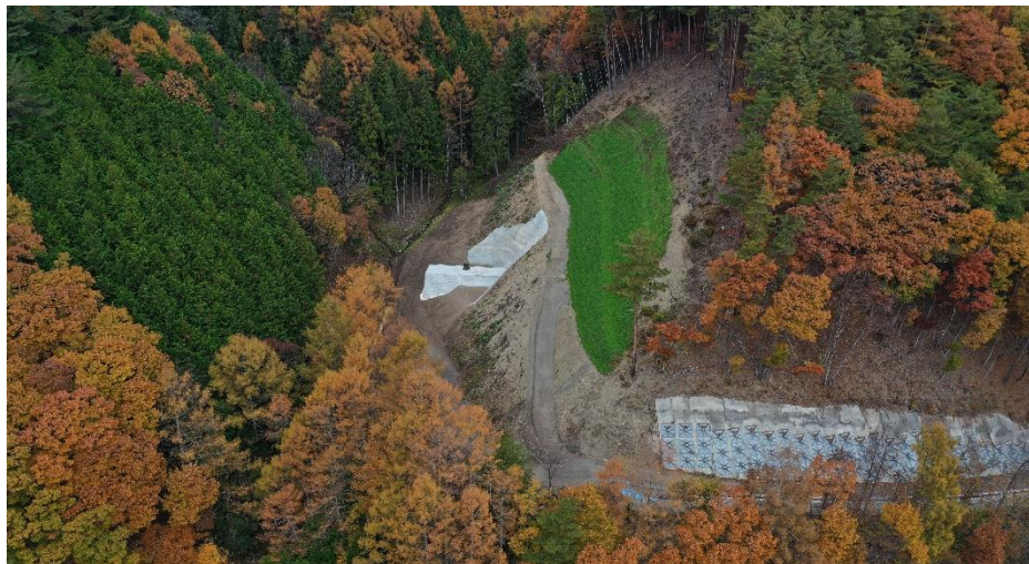
熊倉沢砂防堰堤
