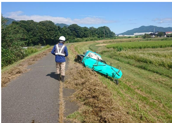
令和6年度天竜川伊那管内堤防維持管理修繕工事 （R6年6月現地状況）
