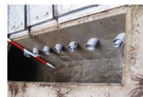
横ポーリング工
