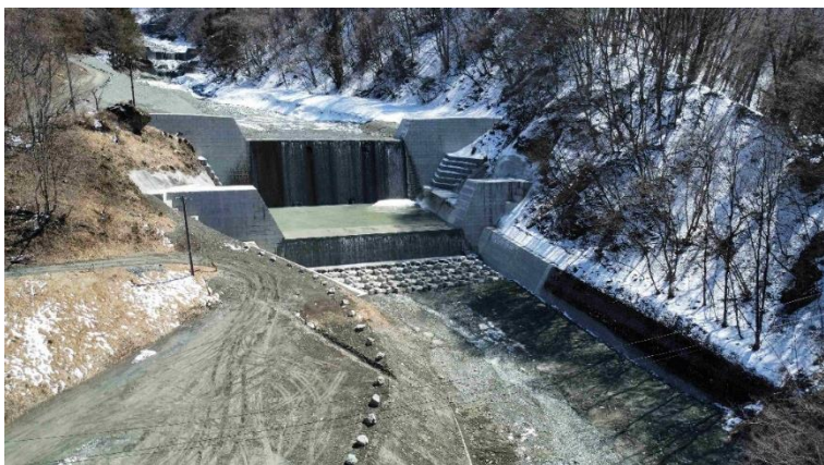
手開沢砂防堰堤改築
