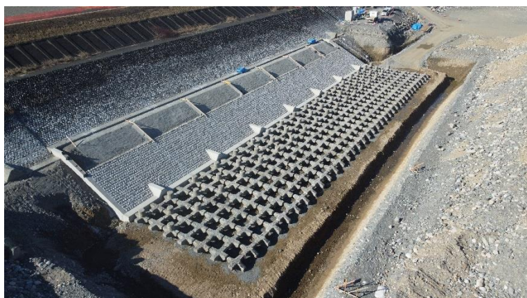
令和6年度天竜川山吹地区護岸修繕工事 （R7年2月現地状況）
