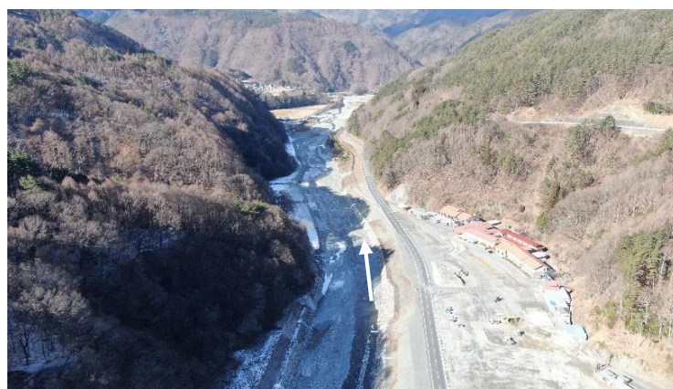
黒川溪流保全工
