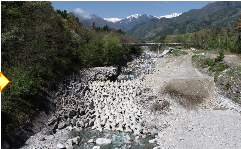
太田切川ブロック堰堤完成 (R4.5)
