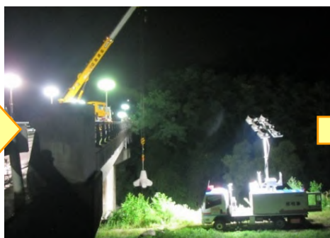
緊急復旧施工 (24時間施工)
