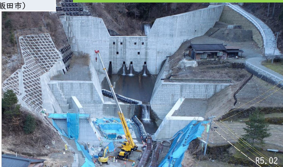
ツベタ沢砂防堰堤
