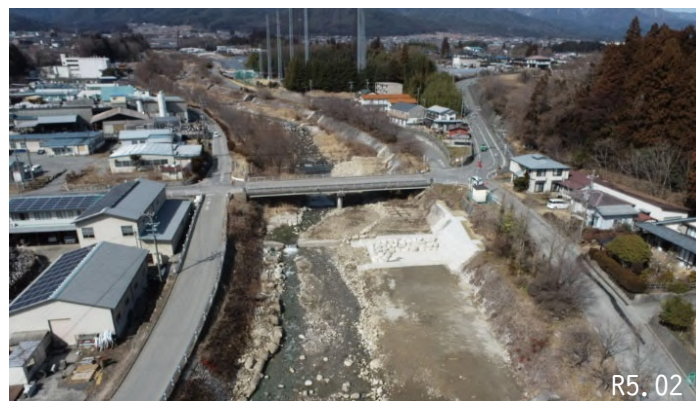
かたぎりまつかわ 片桐松川床固工群
