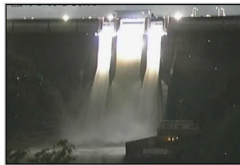
美和ダムの放流状況（R元. 10. 12）
