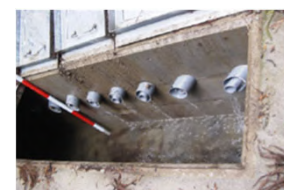
横ボーリング工
