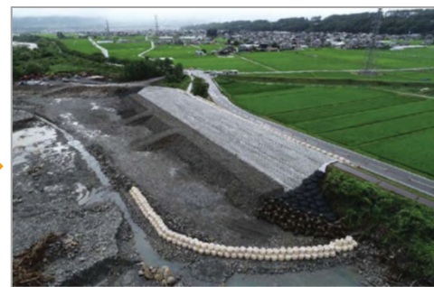
復旧工事完了（R2. 7. 14）
