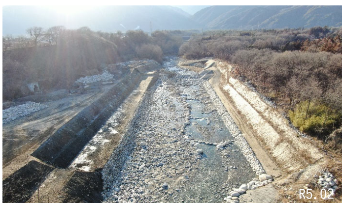
おおたぎり 太田切溪流保全工
