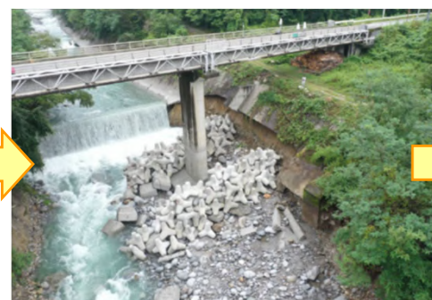
緊急復旧完了 (3日間で完了)
