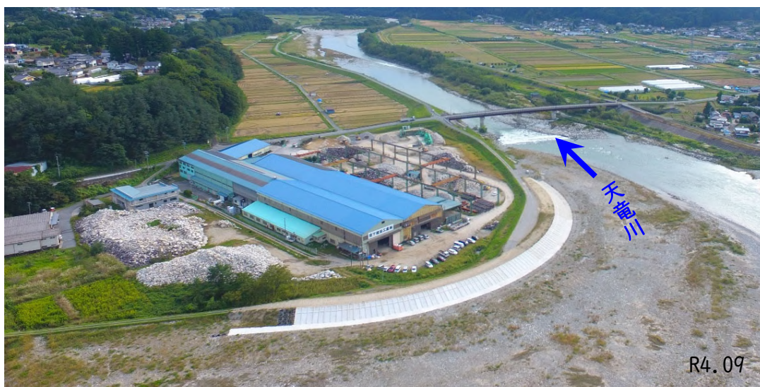
みなかた 南向地区堤防整備事業（堤防整備）
