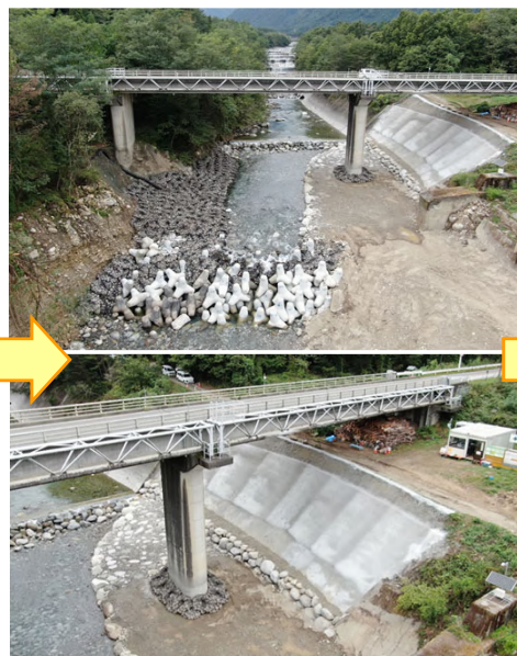
応急復旧完了 (40日間で完了)
