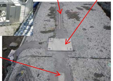
床固工に設置した流砂観測施設の例
