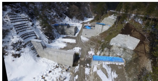
黒川第4砂防堰堤 (現場状況H29.3)
