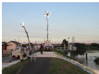
排水ポンプ設置作業と、排水ポンプ車・照明車 (H27.9 茨城県常総市小貝川大和橋付近)
