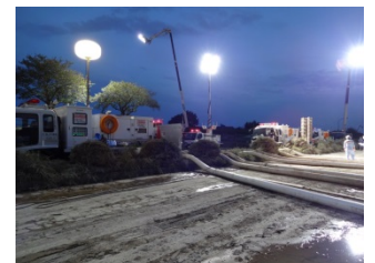
排水ポンプ車による内水排除と、照明車による排水作業支援 (H27.9 茨城県常総市(R294)ロードパーク付近)
