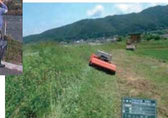
堤防維持管理工事 (ラジコン除草機)
