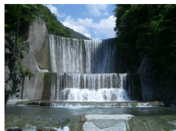
上蔵砂防堰堤
