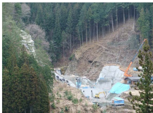
ツベタ沢砂防堰堤 (現場状況H29.3)
