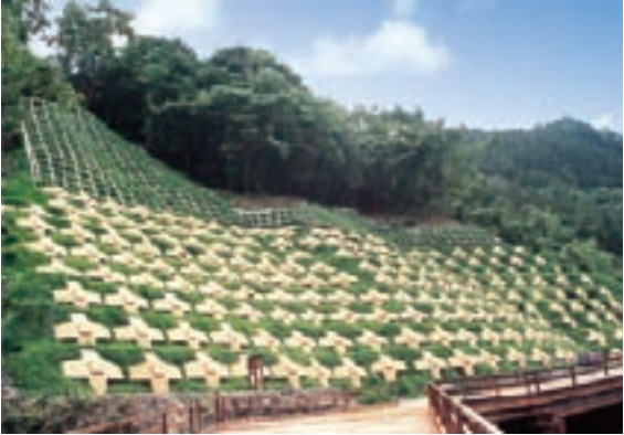
アンカー工・法枠工
