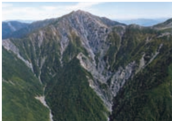
荒川大崩壊地
