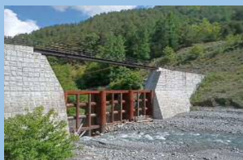
塩川第2砂防堰堤
