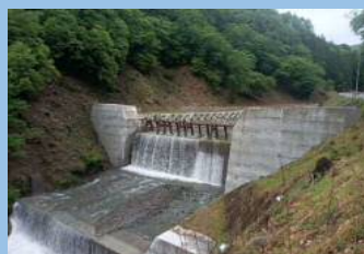
北川砂防堰堤
