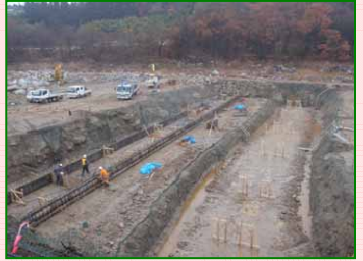
床固本体の型枠組立状況です。
