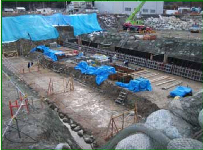
床固本体の型枠組立状況です。
