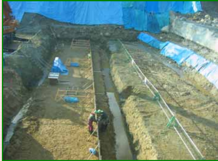
垂直壁型枠組立状況です。
