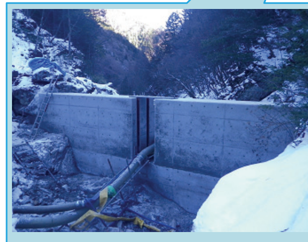
川の流れをトンネルに導くためのコンクリートの擁壁(締切)です
