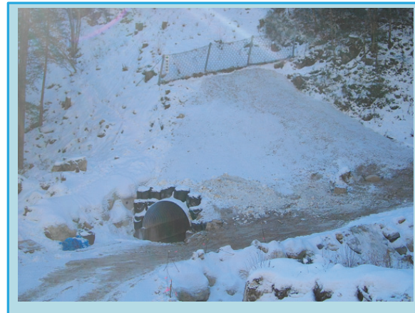
トンネル出口
