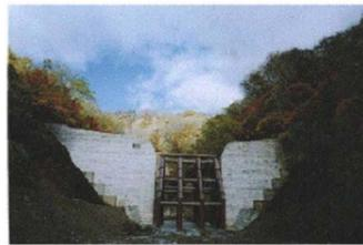
間に隙間があるタイプや鋼製の枠などで土石流を食い止めます高低差が無いので魚などが自由に行き来できる利点があります
