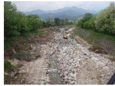
大型重機により作業開始
