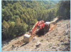
まず、付替道路を設置するため、山を掘削しました。
