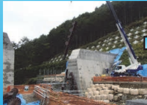
砂防堰堤のスリット部（鋼製）の立込を行っている状況です。
