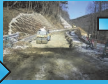
付替道路の盛土部を転圧している状況です。
