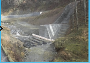
砂防堰堤の建設に入りました。
