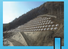
付替道路を掘削面を押さえるためアンカー工などで対策しました。
