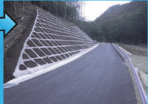
付替道路が完成しました。
