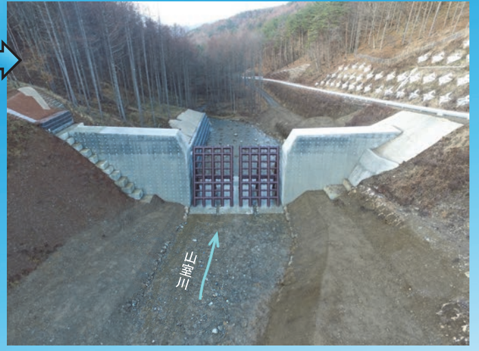
山室第2砂防堰堤の完成です。
