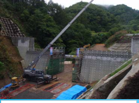
クレーンを現場に設置し、コンクリートのパネル(残存型枠)を溶接で固定し、コンクリートを打設します。
