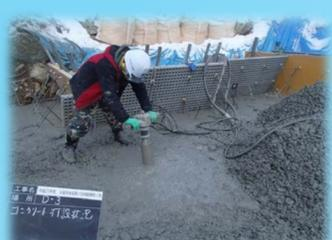
③ おおきなバイブレーターで締め固めます。機械は40kgあるのでとても大変です。
