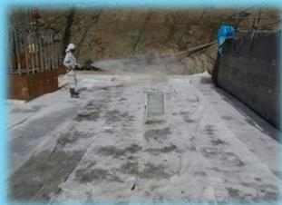
④ 固まる前のコンクリートはデリケート 温度が上がらないように散水します。
